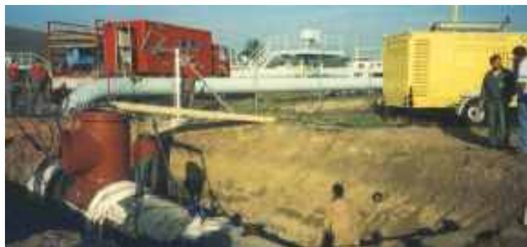
Samostatná žíhací jednotka s naftovým agregátem jako přívěs Výkon generátoru: 130 kW Výkon žíhacího zařízení: 120 kW Schváleno pro silniční provoz do rychlosti až 80 km/h. Oblast použití: Předehřívání plynových potrubí při svařování spojek tvaru T.
